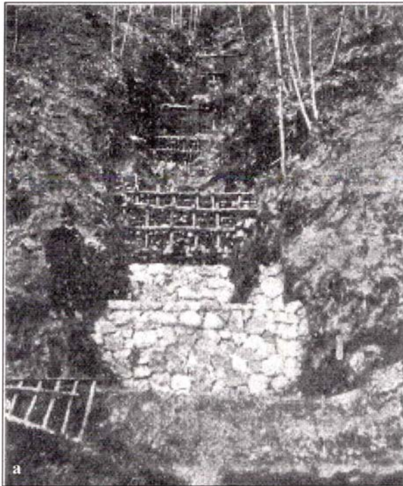
Fig. 1 - Briglia in legname e pietrame (a) e fascinata (b) edificate nel 1912 sotto la direzione dell'ing. La Cava sul Monte Somma.
