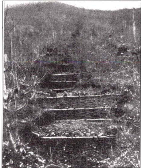
Fig. 1 - Briglia in legname e pietrame (a) e fascinata (b) edificate nel 1912 sotto la direzione dell'ing. La Cava sul Monte Somma.
